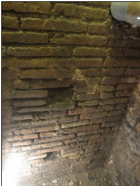
FOTO 3. Vista de l'interior de la fossa sèptica UE 03. Podem veure els forats que facilitaven l'accés i, parcialment, el fonament de l'edifici (a la dreta) al que s'adossa i que actua com un dels seus límits
