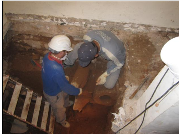
FOTO 5. Desmuntatge de la part afectada del mur UE 09
